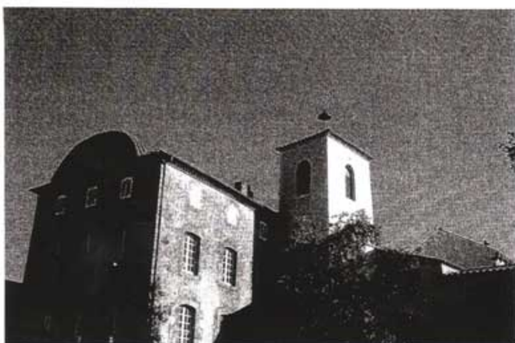
Le corps de bâtiment principal est dominé par l'arrondi typique de l'architecture dite en «chapeau de gendarme»
